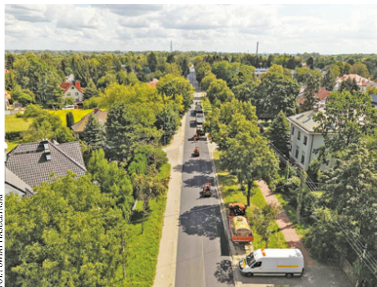
Do zakończenia robót pozostało wykonanie oznakowania poziomego oraz drobne poprawki, w tym korekta studzienek
