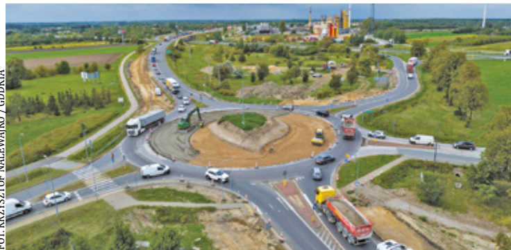
Przebudowa ronda na węźle Mszczonów S8 w związku z rozbudową A2 Łódź-Warszawa
