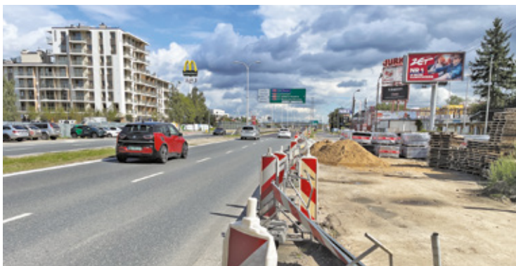
Roboty przygotowawcze przy węźle Warszawa Zachód. Przebudowa ma ułatwić objazdy podczas planowanego poszerzenia autostrady A2
