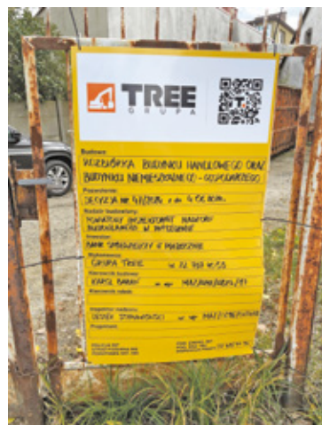
Rozbiórkę prowadzi Bank Spółdzielczy w Piasecznie na podstawie decyzji z 4 czerwca 2024 roku
