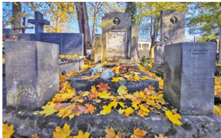
Zabytkowy grób Cezarego Lachowicza, dawnego wiceburmistrza Piaseczna. Popękane płyty i uszkodzona tablica z nazwiskiem pokazują, jak pilnie pomnik potrzebuje renowacji
