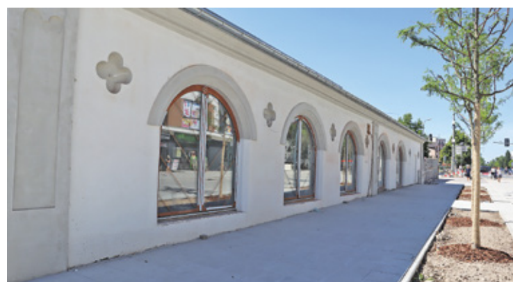
Rewitalizacja budynku może się nieco przedłużyć
