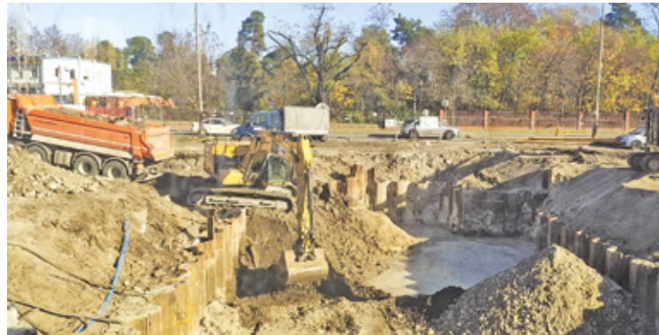
Przy stacji kolejowej powstał m.in. bąpas, który zapewnia kursowanie pociągów, a także nowy budynek nastawni (docelowo znajdzie się tam lokalne centrum sterowania)
