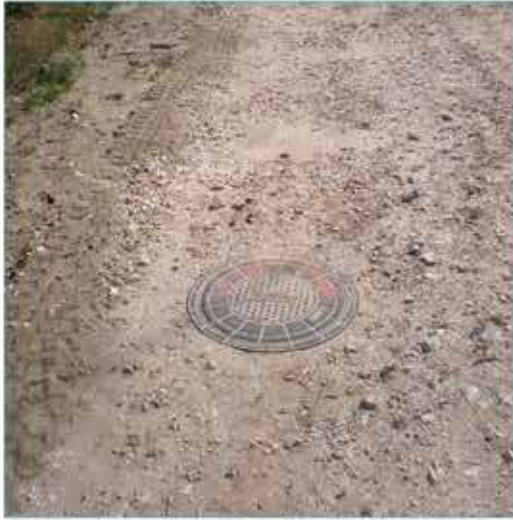
Kanalizacja sanitarna - Brzeście ul. Leśna 2
