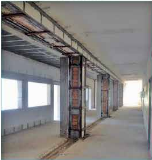
Rozbudowa Szkoły w Baniosze
