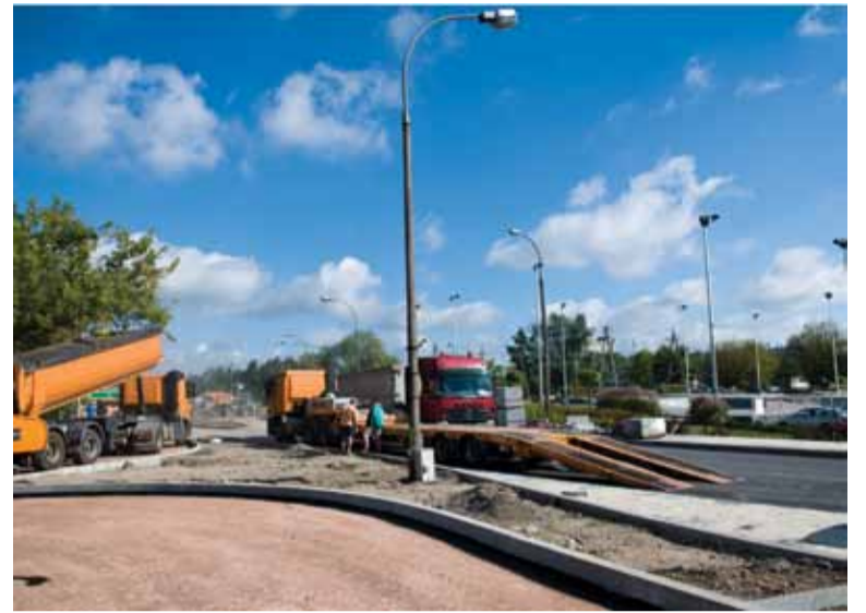
We wtorek trwały prace przy tworzeniu łącznika z ulicą Sikorskiego
