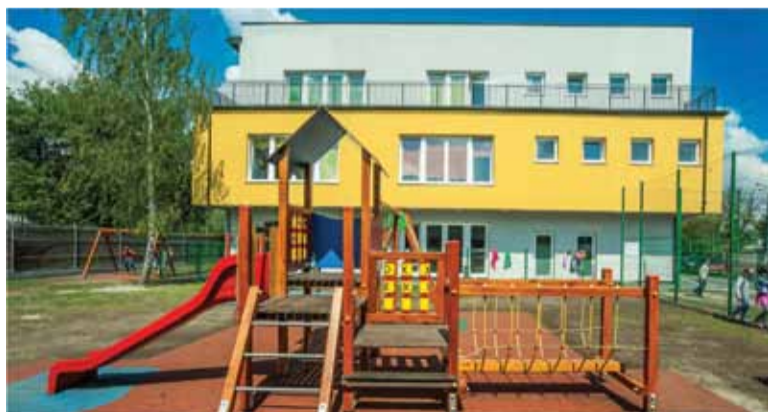
Szkoła Podstawowa nr 5 przy Orężnej
