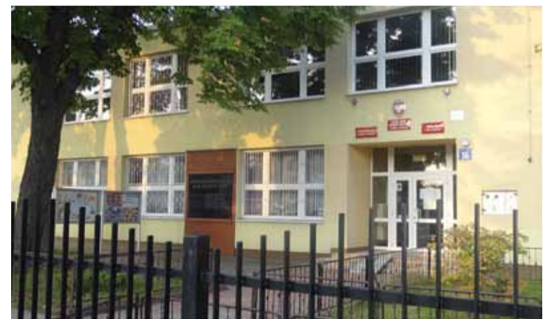
Budynek Zespołu Szkół Ogólnokształcących w Górze Kalwarii
