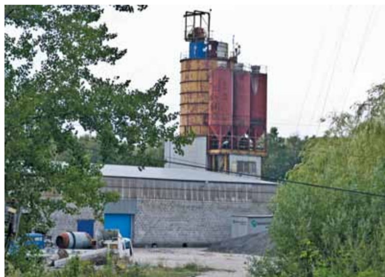
Asfalcjarnia miałyby powstać na terenie nieczynnej fabryki betonu w Gąskach
