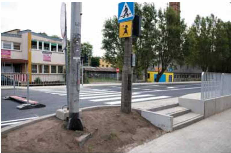
Od strony bazarku zdecydowanie brakuje miejsca na podjazd dla wózków.
