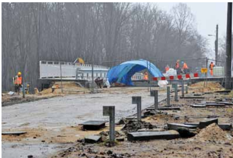
Zdaniem rzeczownika PKP PLK przy wiadukcie trwają ostatnie prace
