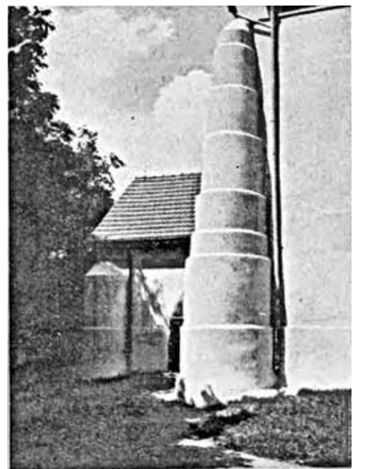
Kościół św. Anny w Piasecznie z 1914 roku z otynkowanymi ścianami
