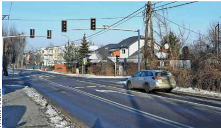
Jedną z większych inwestycji ma być przebudowa ul. Geodetów w Józefostawiu
