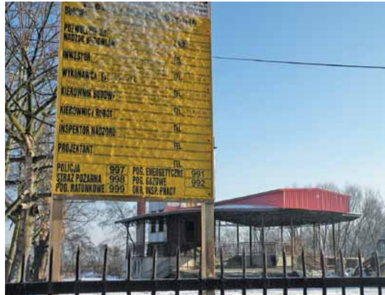
„Można było się spodziewać, że zimą prace ziemne nie będą wykonywane we właściwym tempie”
