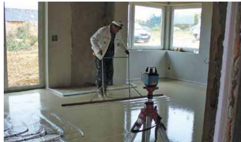
Baumit – zalewanie rur grzewczych płynnym jastrychem
