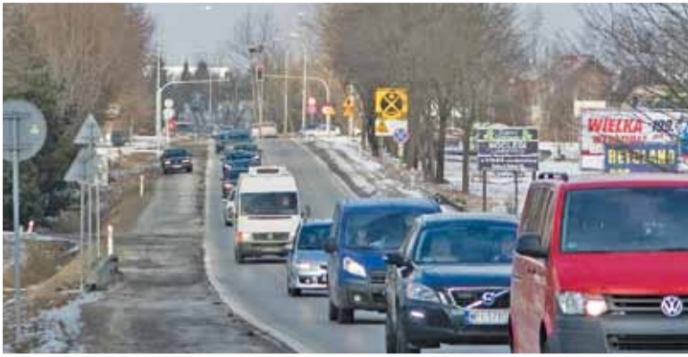
Przebudowa dłuższego odcinka DK 79 to na razie odległa przyszłość
