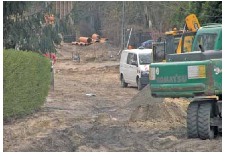
Obecnie trwa przebudowa ulicy Saneczkowej
