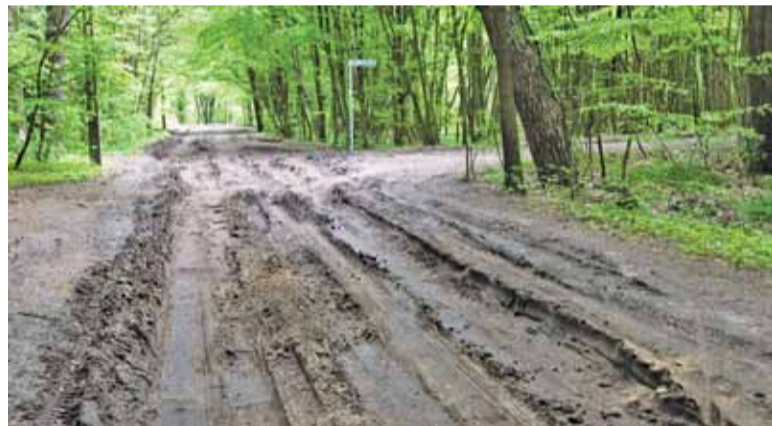
Głębokość kolein wskazuje na przejazd ciężkich pojazdów
