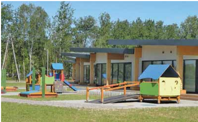
Budynek zdecydowanie wyróżnia się na tle innych
