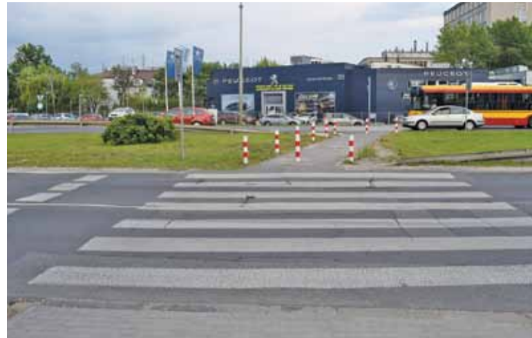
To niezwykle niebezpieczne przejście zostanie przesunięte w rejon skrzyżowania
