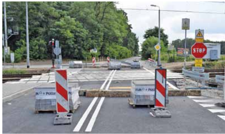
Przejazd w Jeziórku jest gotowy, ale dalej nieprzejezdny
