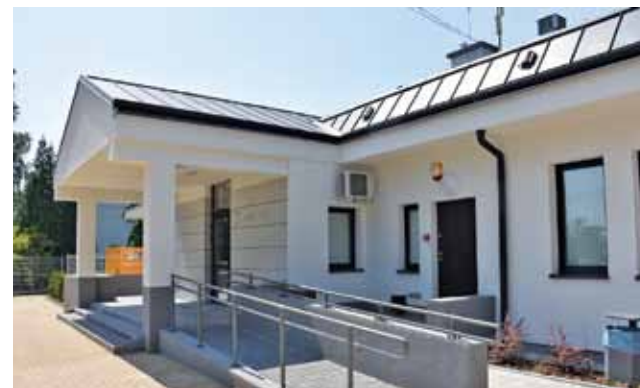
Przychodnia w nowej odsłonie
