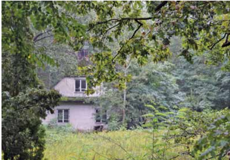
„Domek ogrodnika” po śmierci Piędziów przejdzie na własność D. Sąd niedorzeczne jest, aby to Piędziowie go remontowali
