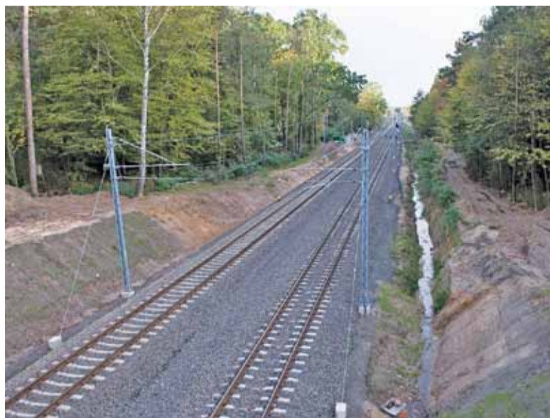
Odwodnienie torów ponoć jest wykonane prawidłowo
