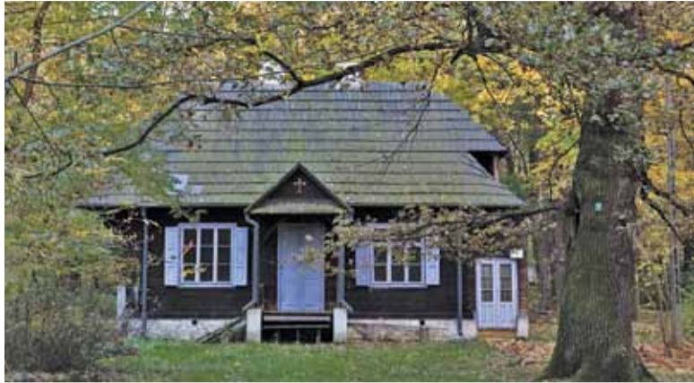
Dom Zośki wymaga pilnego remontu
