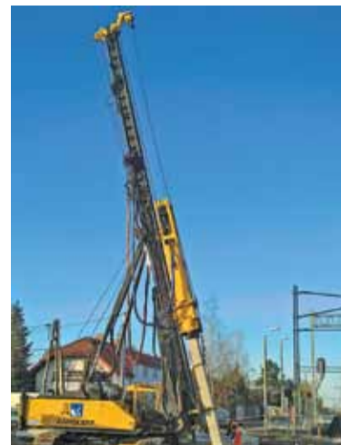
Rozpoczęcie budowy wiaduktu
