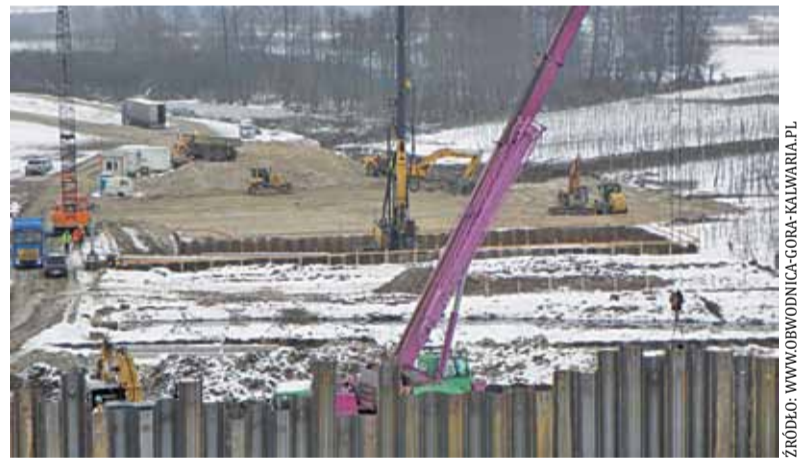
Prace przy obwodnicy Góry Kalwarii
