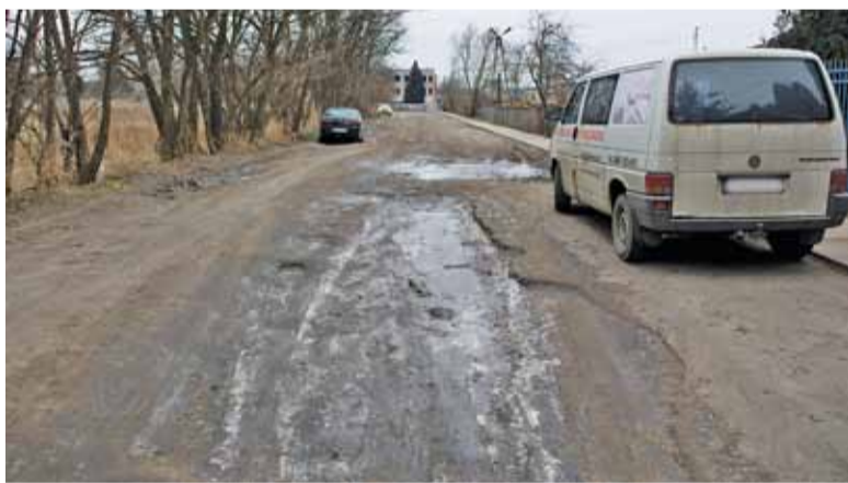
W pierwszej kolejności ma być przebudowany istniejący odcinek ulicy
