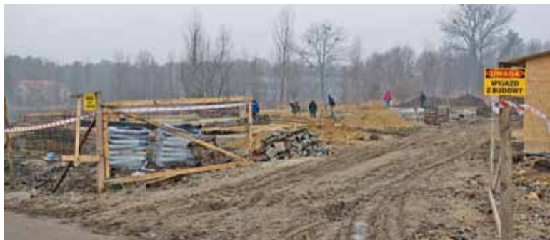
Prace na budowie trwają nawet w sobotę
