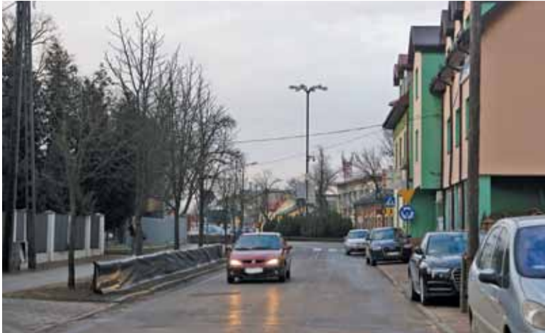
Wjazd w ul. Świętojańską od strony Ronda Solidarności działa od kilku dni
