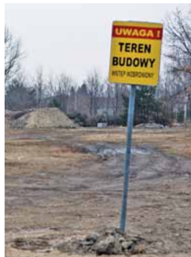
Tablice informujące, że jest to „teren budowy” stoją tu od jesieni
