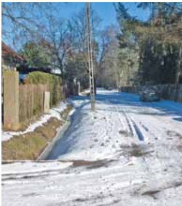
Istniejące rowy odwodnieniowe zostaną oczyszczone i utwardzone
