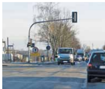
W pierwszej kolejności drogowcy zajmą się pracami na wschodnim poboczu drogi
