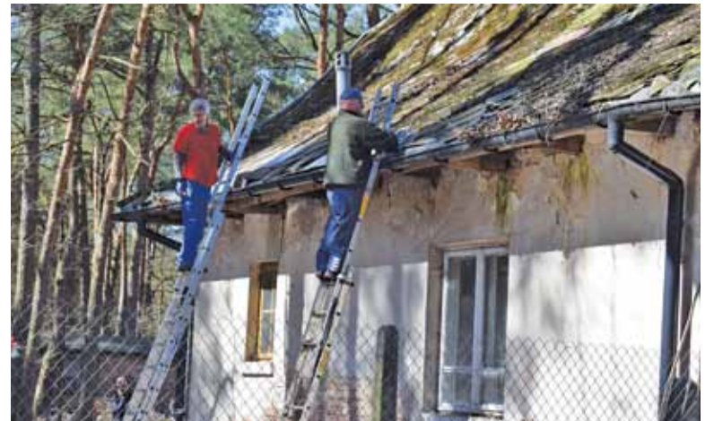
Na razie wyczyszczono rynny i załatano dziury w dachu
