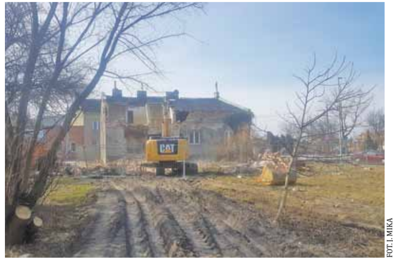
W ubiegłym tygodniu rozebrano kamienicę przy ul. Nadarzyńskiej 10
