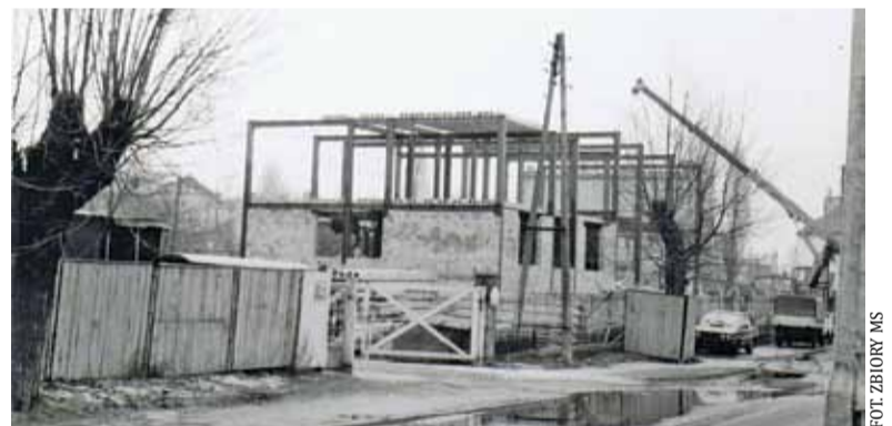
Budowa banku na ul. 22 Lipca
