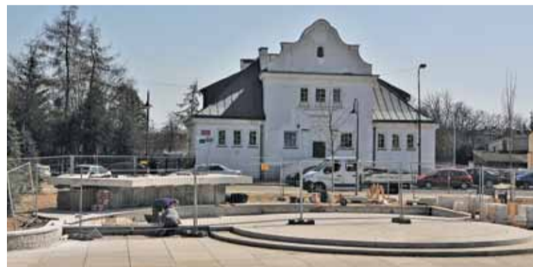
Firma wykonawcza prowadzi prace wykończeniowe przy fontannie
