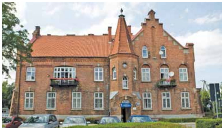
W ubiegłym roku najwięcej głosów zebrał projekt modernizacji kamienicy przy ul. Mirkowskiej 56
