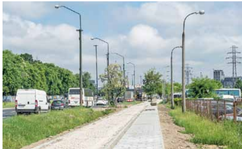
Ciąg pieszo-rowerowy po zachodniej stronie Puławskiej na odcinku od węzła „Wyścigi” do Poleczki w trakcie remontu
