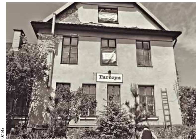
Budynek stacji kolejki wąskotorowej w Tarczynie
