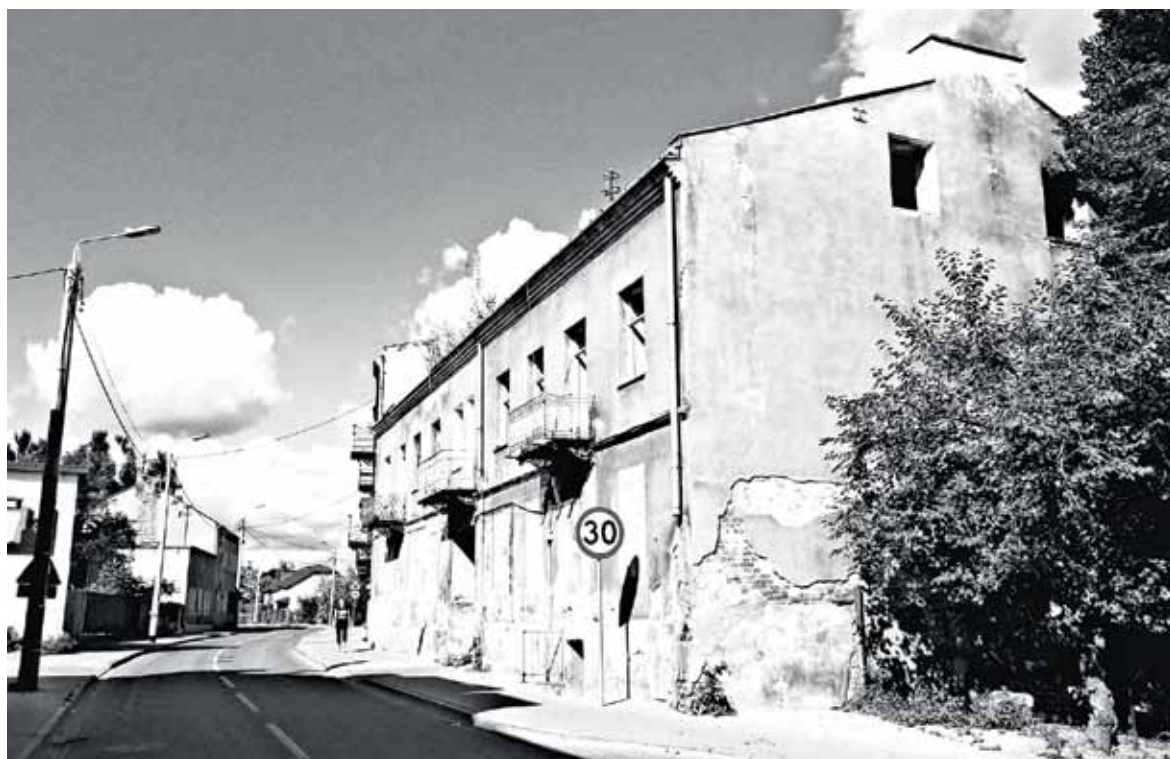
Kamienica frontowa przy ul. Nadarzyńskiej 4
