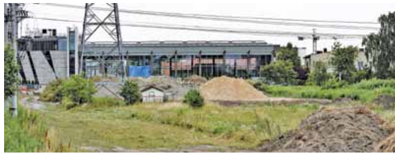
Dzisiaj betoniarnia funkcjonuje przy Okulickiego
