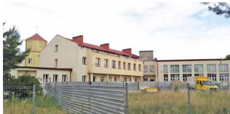
W Pęcherach trwają już prace przy rozbudowie budynku
