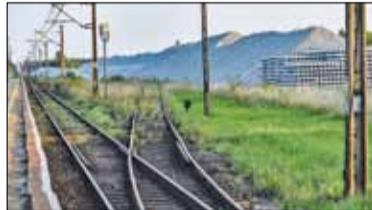
|| Kolej – Rusza kolejna część remontu s. 4
