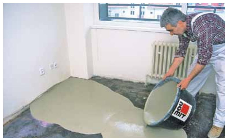
Wykonanie wylewki z masy samopoziomującej
