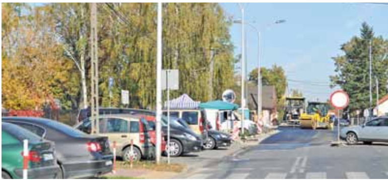
Prace wykończeniowe trwają, ale na otwarciu skrzyżowania trzeba poczekać
