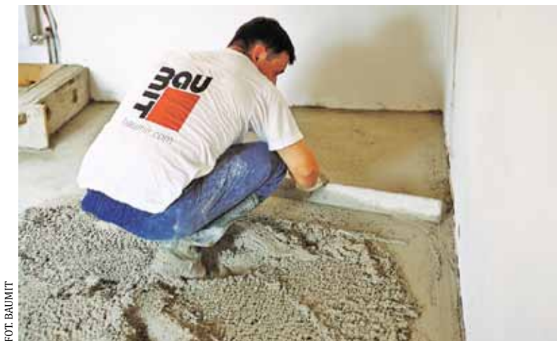
Wykonanie szybko wiążącej posadzki cementowej
