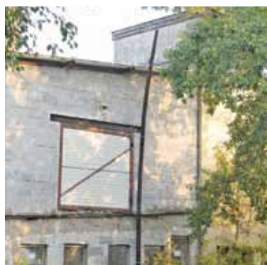
Dzięki przedłużeniu kominą dym unosi się powyżej budynku
