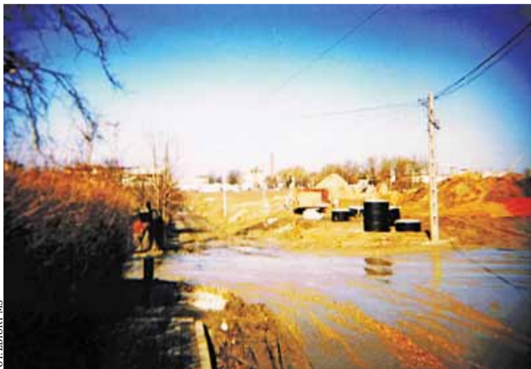
Budowa kanalizacji na ulicy Kniaziewiczza, 2000 r.
