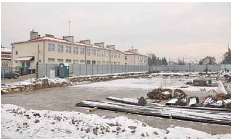
W 2019 roku gmina będzie kontynuować rozbudowę szkoły w Nowej Iwicznej
