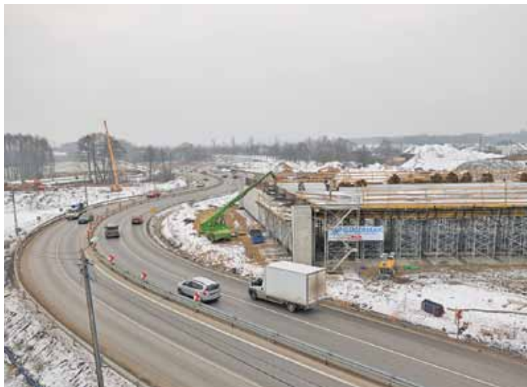
Powiat bierze pod uwagę m.in. trwającą budowę obwodnicy Warszawy
