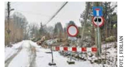
Wycinka jest niezbędna dla budowy ciągu pieszo-rowerowego
