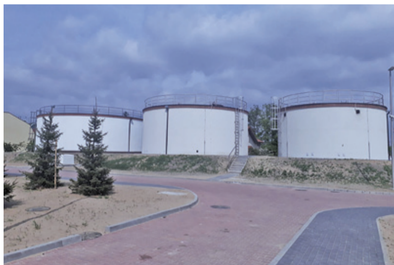
Przebudowana stacja przy Żeromskiego będzie mogła wyprodukować 260 metrów sześciennych wody na godzinę
