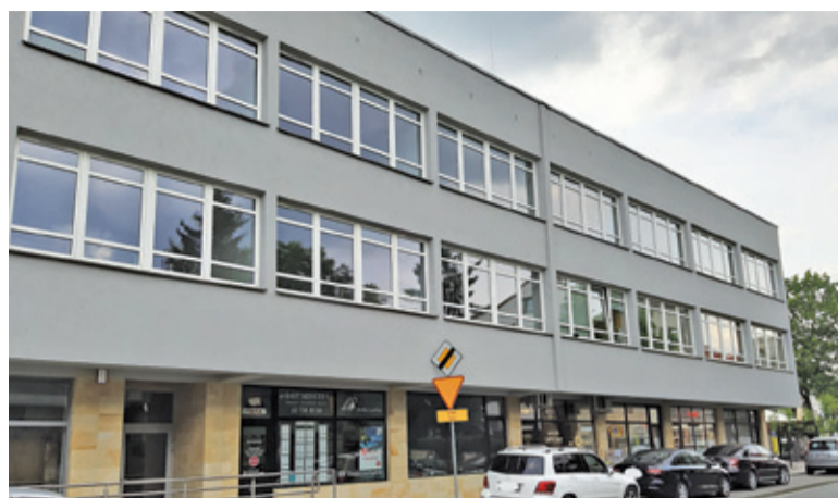
Pozostało już tylko umeblowanie pomieszczeń i przeprowadzka urzędników
