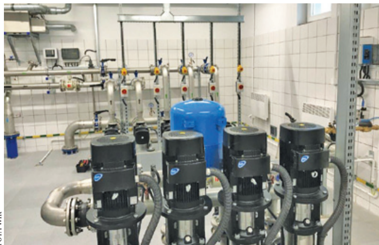
Dzięki modernizacji SUW Bobrowiec mieszkańcy okolicy nie będą już mieli problemów z ciśnieniem wody podczas upałów
