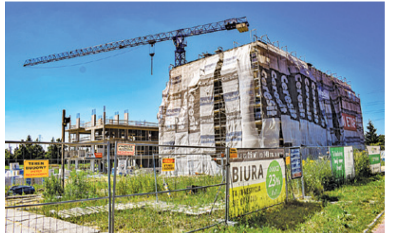
W marcu br. budowa przy Mleczarskiej stanęła, jednak inwestor otrzymał pozwolenie na wznowienie prac
