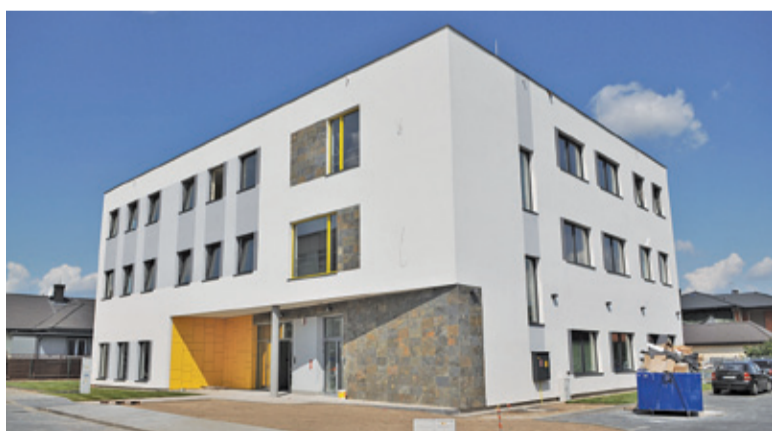
W szkole trwają ostatnie prace wykończeniowe
