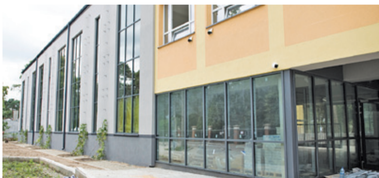
W części sportowo-edukacyjnej trwają jeszcze prace wykończeniowe
