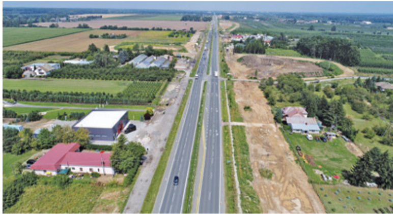
Prace budowlane są na razie prowadzone na odcinku C – od Grójca do Tarczyna
