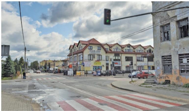
Przebudowa skrzyżowania ma ruszyć na początku października
