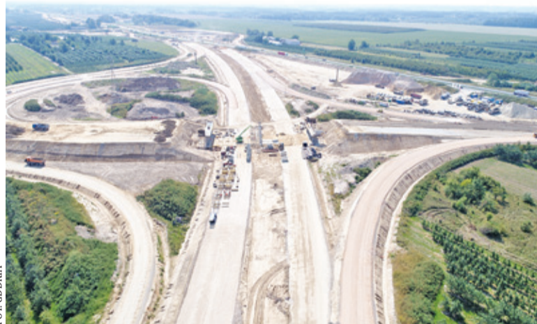
Prace na odcinku między Tarczynem a Grójcem są już zaawansowane
