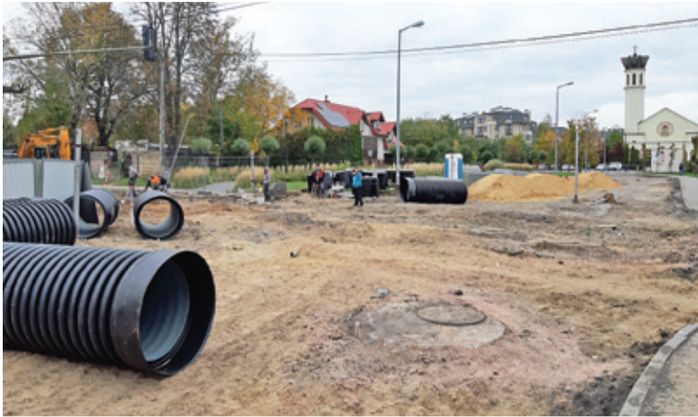
Prace budowlane rozpoczęły się przed tygodniem
