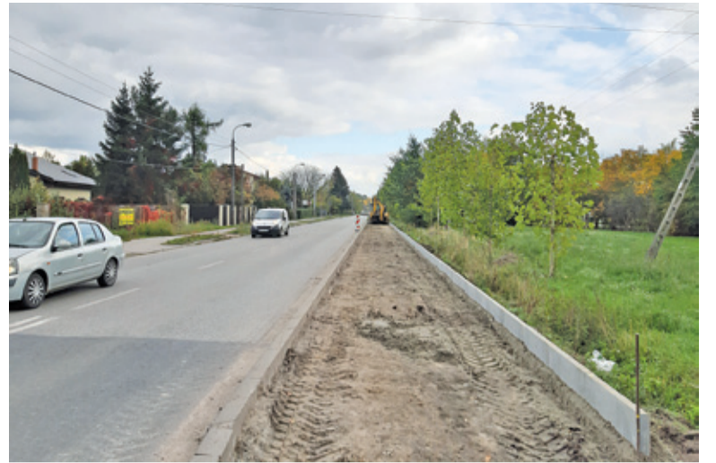
To kolejny etap prac przy tworzeniu sieci dróg rowerowych
