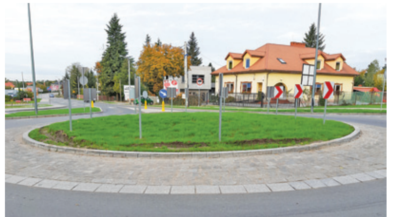
Rondo w Gołkowie zdecydowanie usprawniło komunikację na skrzyżowaniu
