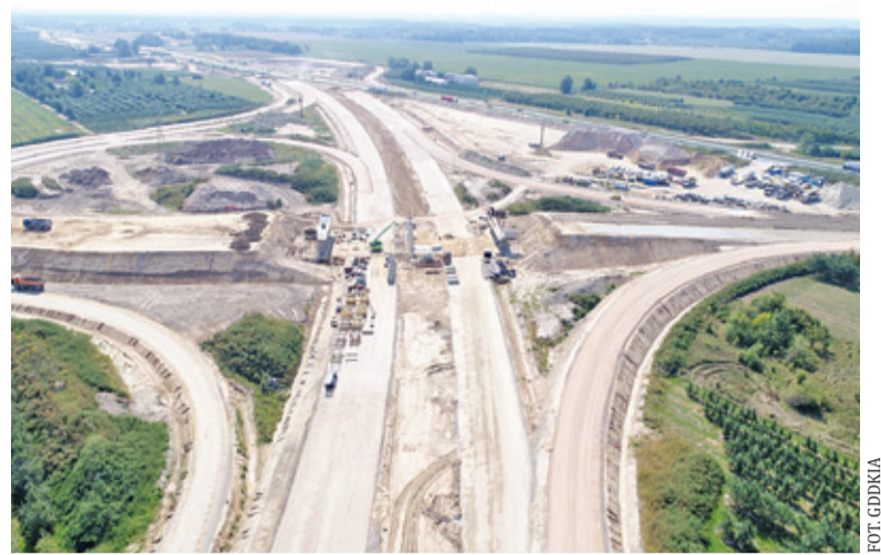
Obecnie trwają prace przy budowie odcinka od obwodnicy Grójca do Tarczyna
