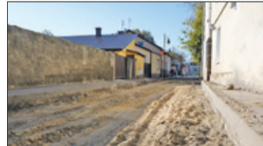
|| Góra Kalwaria - Remont Strażackiej s. 6
