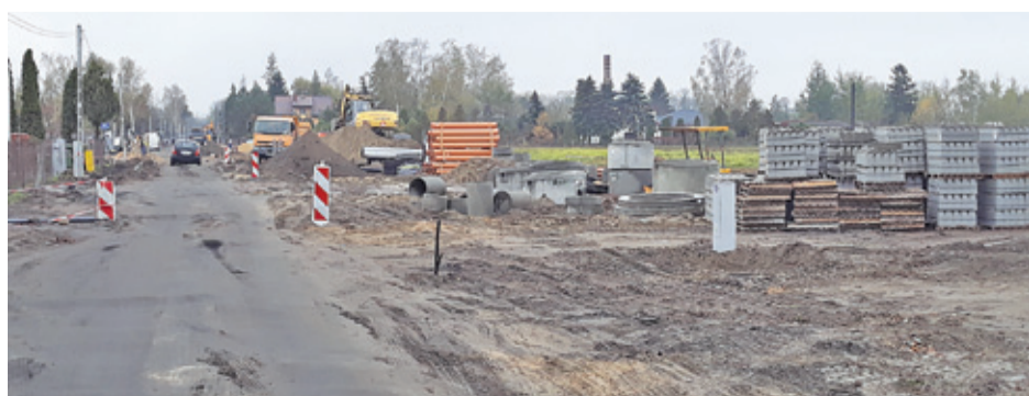
Roboty budowlane w Wólce Kosowskiej, stan na 29.10.2019 r.
