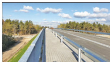
|| Góra-Kalwaria - Wiadukt już otwarty s. 6
