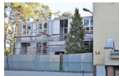
Rozbudowa budynku ZS Nr 2 w Piasecznie
