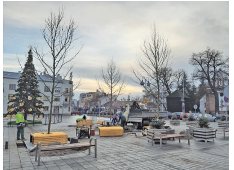
We wtorek trwały jeszcze prace wykończeniowe
