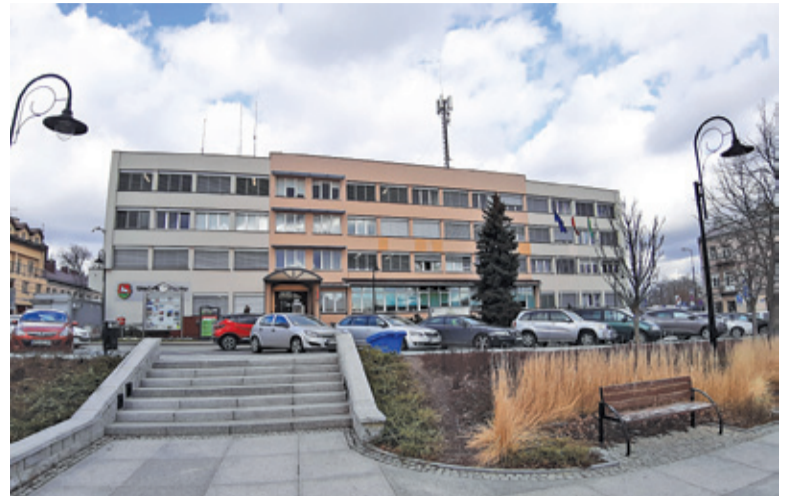
Dach Urzędu Gminy ma być maksymalnie wykorzystany pod budowę instalacji fotowoltaicznej
