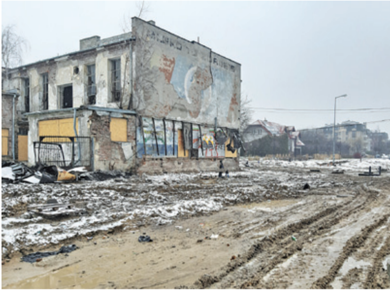
Mieszkańcy narzekają, że na placu budowy niewiele się dzieje
