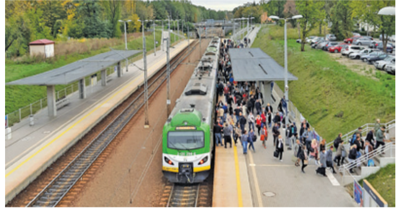
Opracowanie studium wykonalności ma dotyczyć między innymi budowy dwóch dodatkowych torów z Warszawy do Piaseczna, a nawet Czachówka
