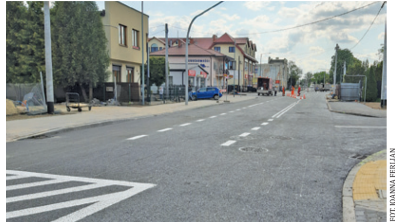
Obecnie trwają ostatnie prace na odcinku między ul. Powstańców Warszawy a ul. Jarząbka
